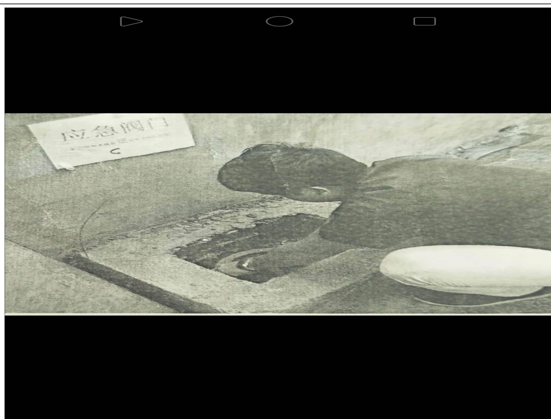
图 10-5 关闭后并打开应急池阀门
