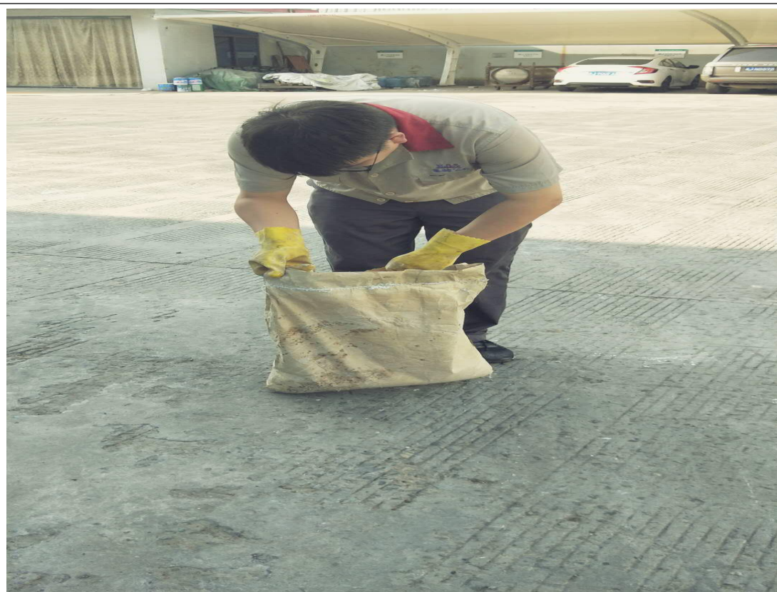
图 10-6 应急人员到达现场，利用消防沙对泄露区域进行围堰并利用消防沙进行吸附，用工具将含有盐酸的沙收集装袋后暂存放危废堆场
